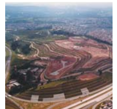
The Bandeirantes landfill
